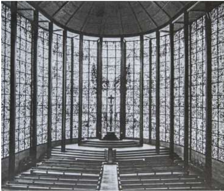
Innenraum der Stahlkirche, Köln 1928
