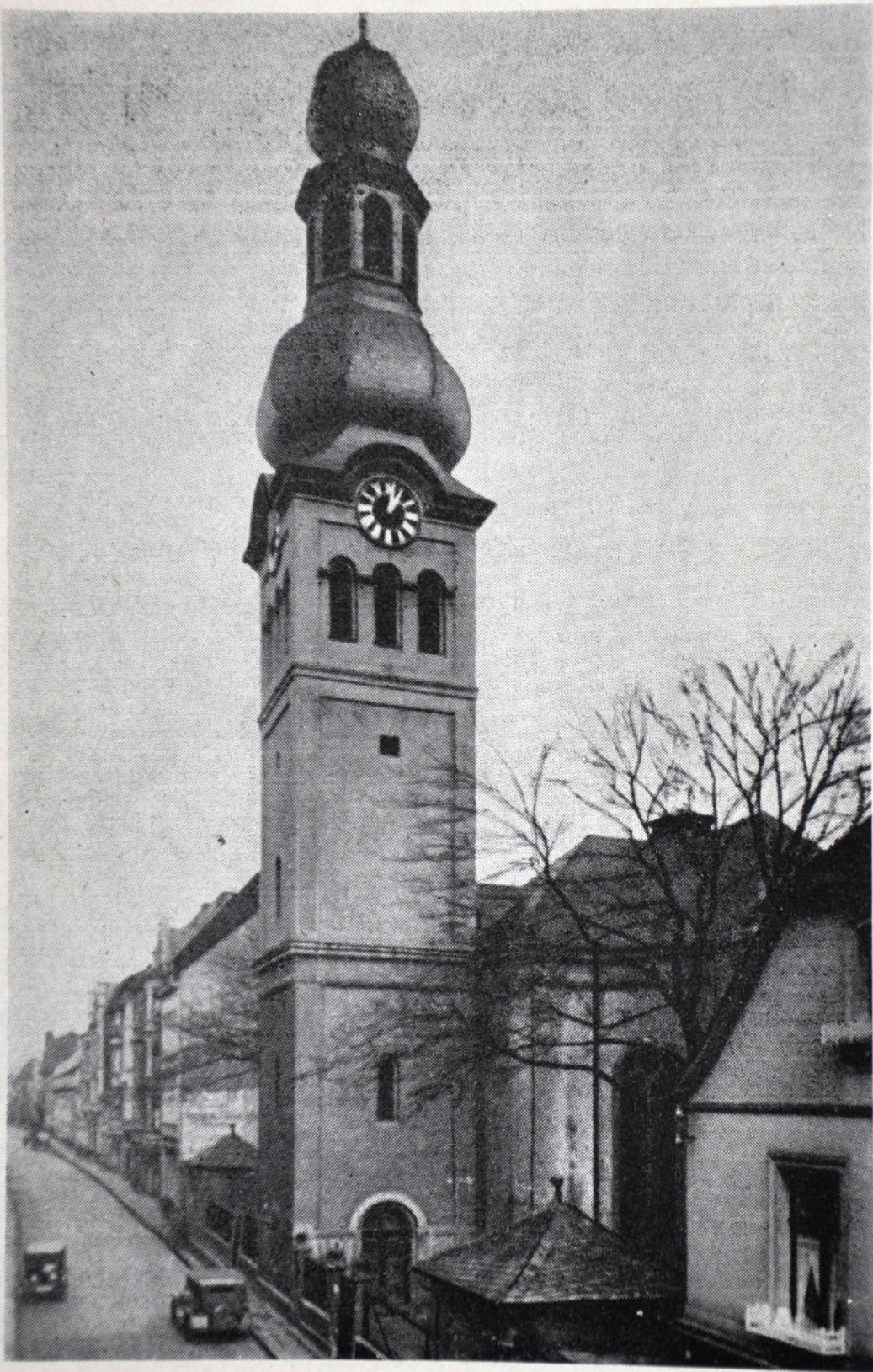
Die Friedenskirche nach der Erneuerung 1935
